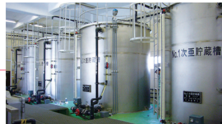
チタン製槽類 浄水場貯蔵槽(次亜貯蔵槽) 15M 3 外径2.8M×高さ3.0M
