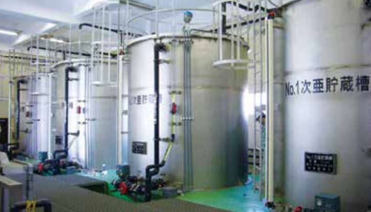
チタン製槽類 浄水場貯蔵槽(次亜貯蔵槽) 15M³ 外径2.8M×高さ3.0M
