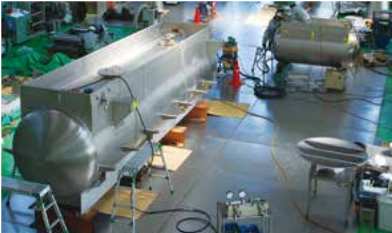
タンクローリー用タンク製作風景
